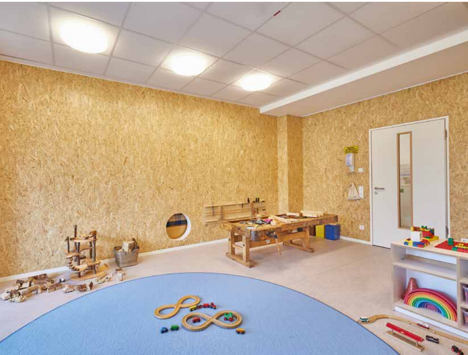
Die großflächigen schallabsorbierenden Holzwolleplatten verleihen dem Werk- und Bauraum im FRÖBEL-Kindergarten & Familienzentrum Wirbelwind eine authentische Werkstattästhetik.
