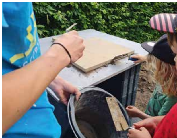
Gemeinsam entschieden die Kinder und das Team im FRÖBEL-Kindergarten Springfrosch in Potsdam, einen Lehmofen zu bauen. Unterstützung bekamen sie von den Familien und einigen Schulkindern.
